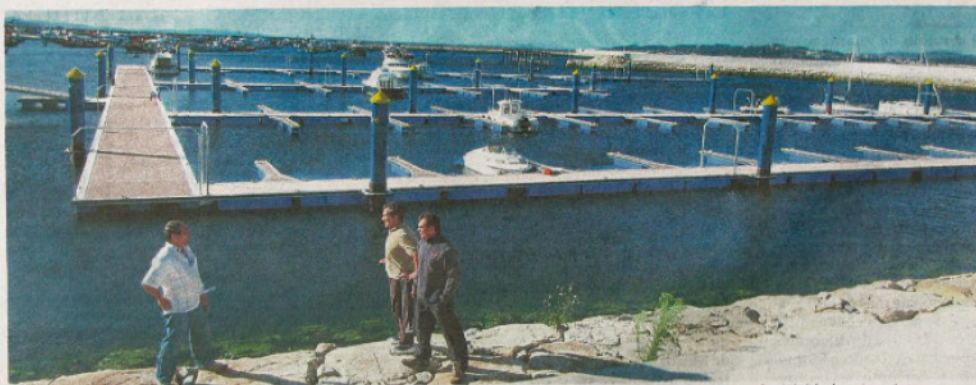
Los pantalanos están concluidos y en las próximas semanas serán completados con los servicios de agua y electricidad, entre otros.
