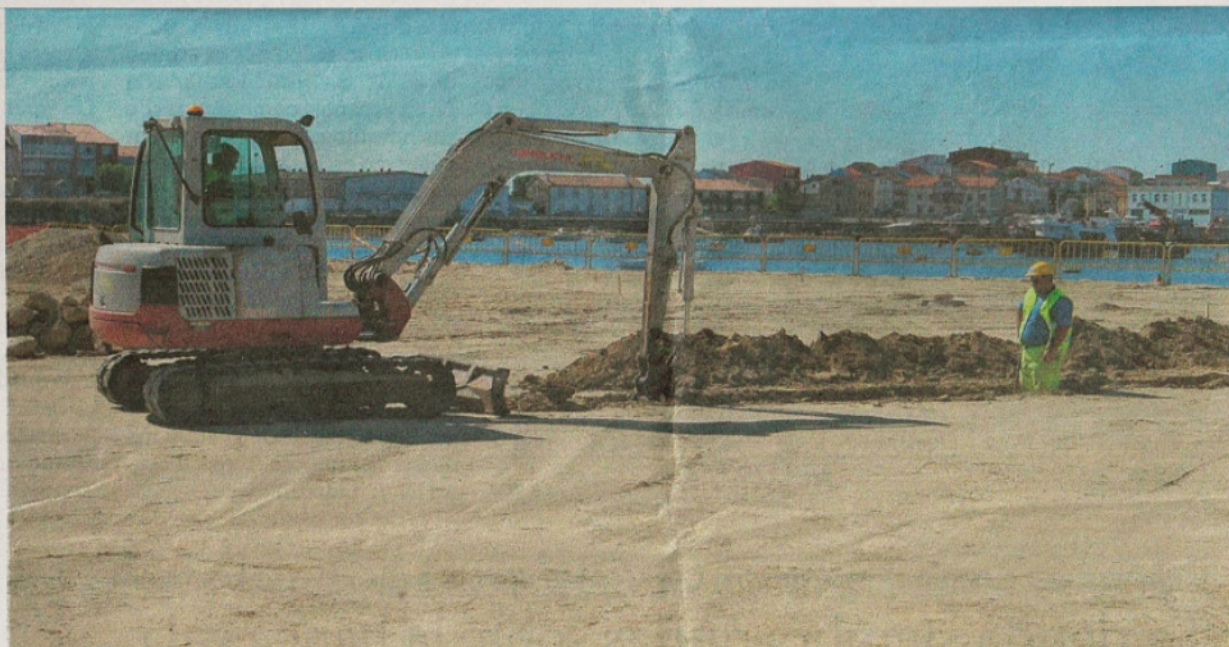
Los trabajos se están desarrollando estos días en el relleno sobre el que se construirá la sede del náutico. SIMÓN BALVÍS
