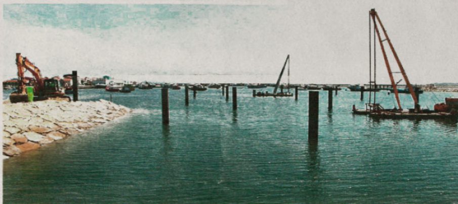
RÁPIDO AVANCE DE LAS OBRAS
