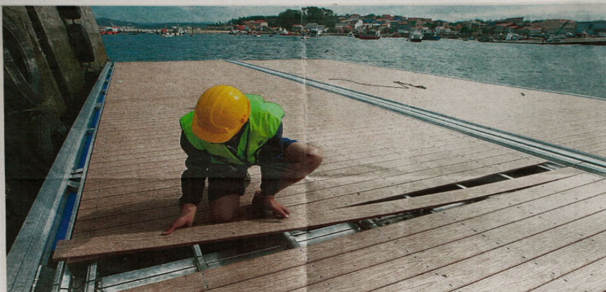
Los operarios comenzaron ayer el ensamblaje de las enormes piezas que darán forma al pantalán central, de 120 metros de largo. SIMÓN BALVÍS
